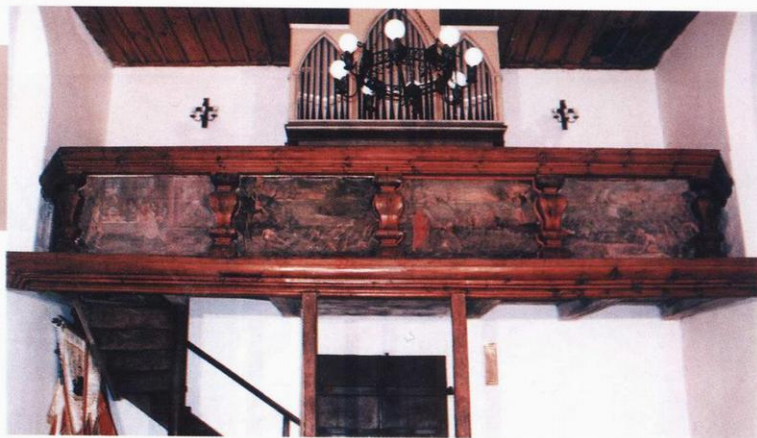
Widok na balustradę empyry organowej kościoła w Rogowie. Dwie skrajne i załamane wnęki są miejscem ekspozycji obrazów „Chrzest Jezusa w Jordanie” oraz „Zmartwychwstanie”. Fot. Damian Lizun.
